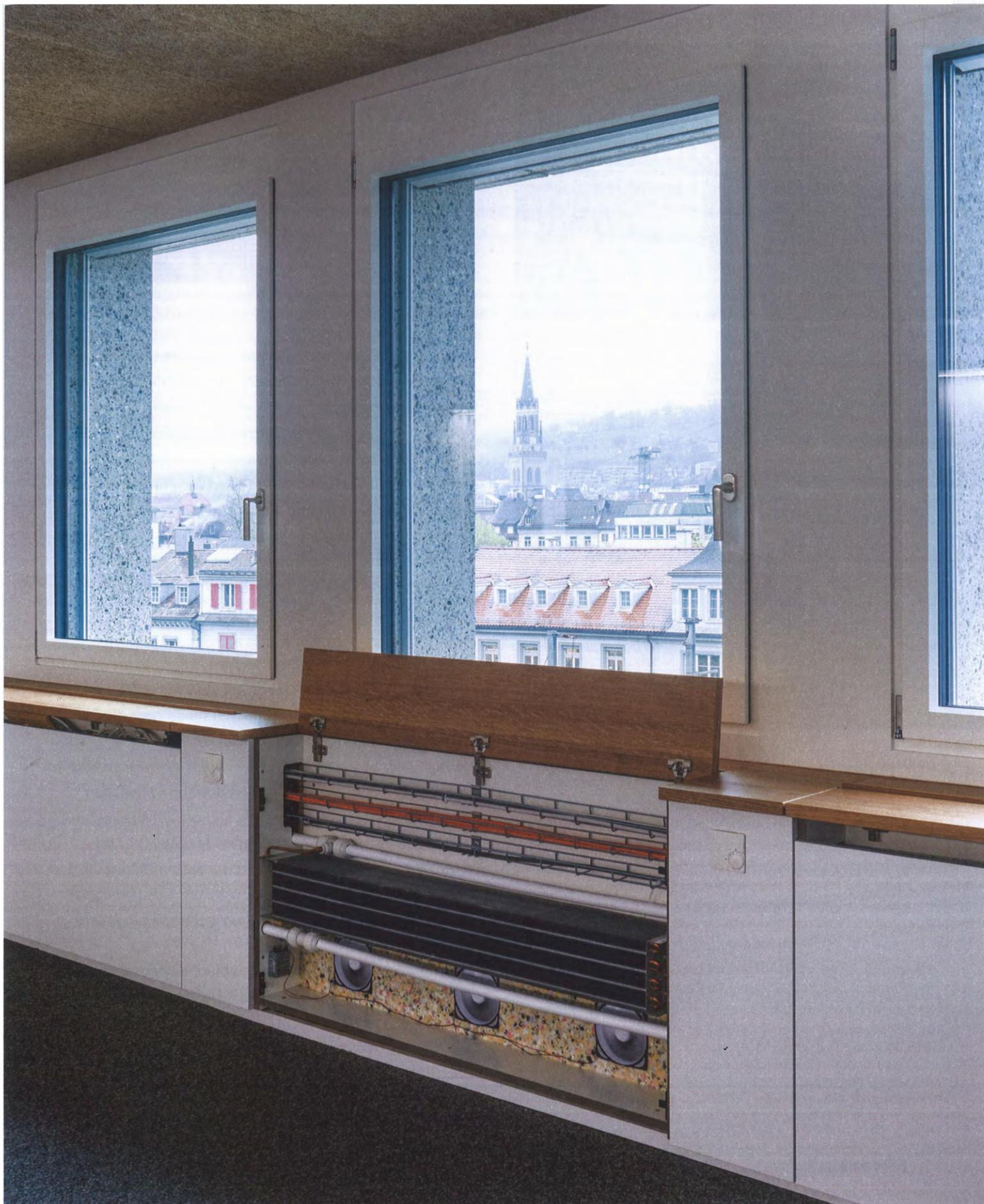
Die Fensterbrüstungen sind in allen Räumen mit Luftkonvektoren besetzt, die sich zur Verteilung von Niedertemperaturwärme eignen.
