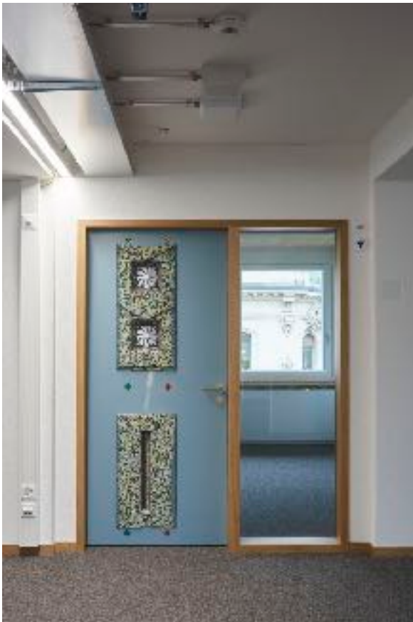
Abb. 1: Verbundlüfter in Türblättern (Abdeckung entfernt)
