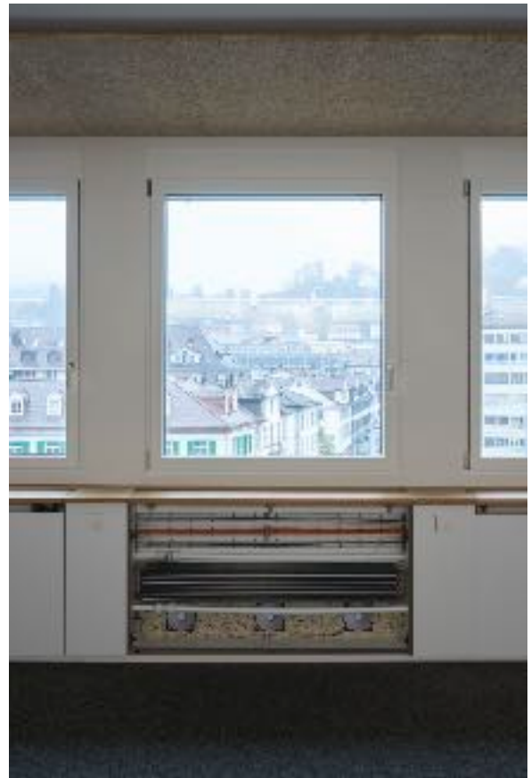
Abb. 2: Brüstungskanal (Abdeckung entfernt)
