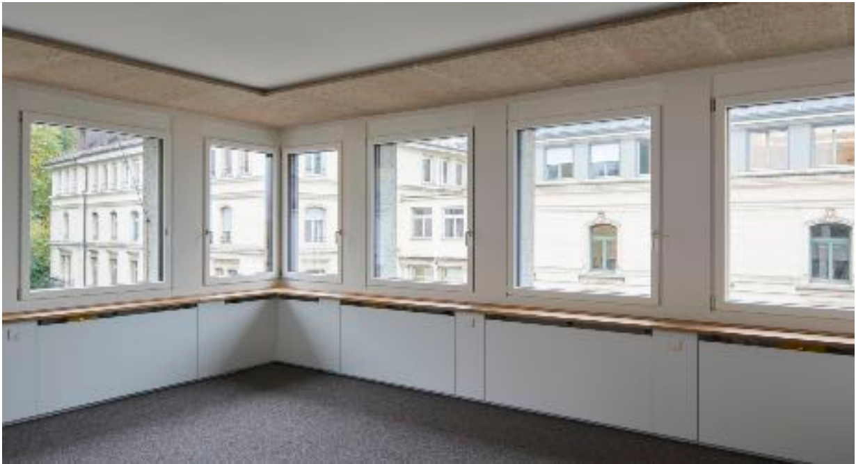
Abb. 4: Neue Holzfenster, 16cm Isofloc-Dämmung in Brüstungskanal und Streifendämmung an Decke
