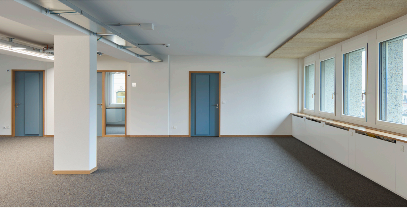
Die Decke ist bis auf einen Randstreifen (zur Dämmung und für die Akustik) sowie einen zugänglichen Elektrokanal freigelegt.
