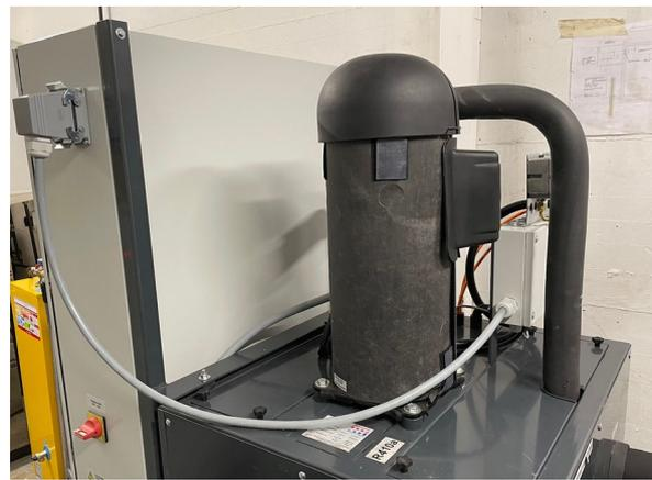
Abbildung 5: Rechts: Klimakonvektor (Heizkörperersatz). Rechts: Niederhub-WP mit drehzahlgeregeltem Scroll-Kompressor, realisiert durch die BMS Energietechnik AG, Wilderswil.
